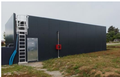
650kg de déchets verts/jour, 2Nm 3 /h de biogaz, 7kWc
