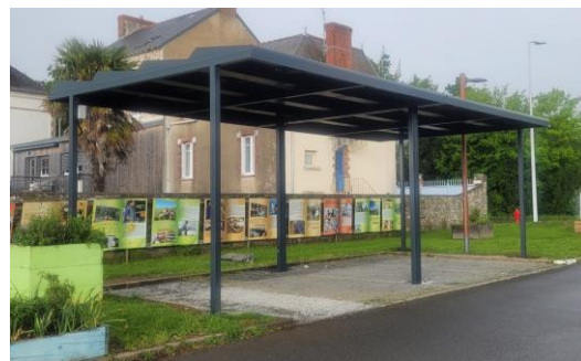
24 panneaux PV, 7kWc
